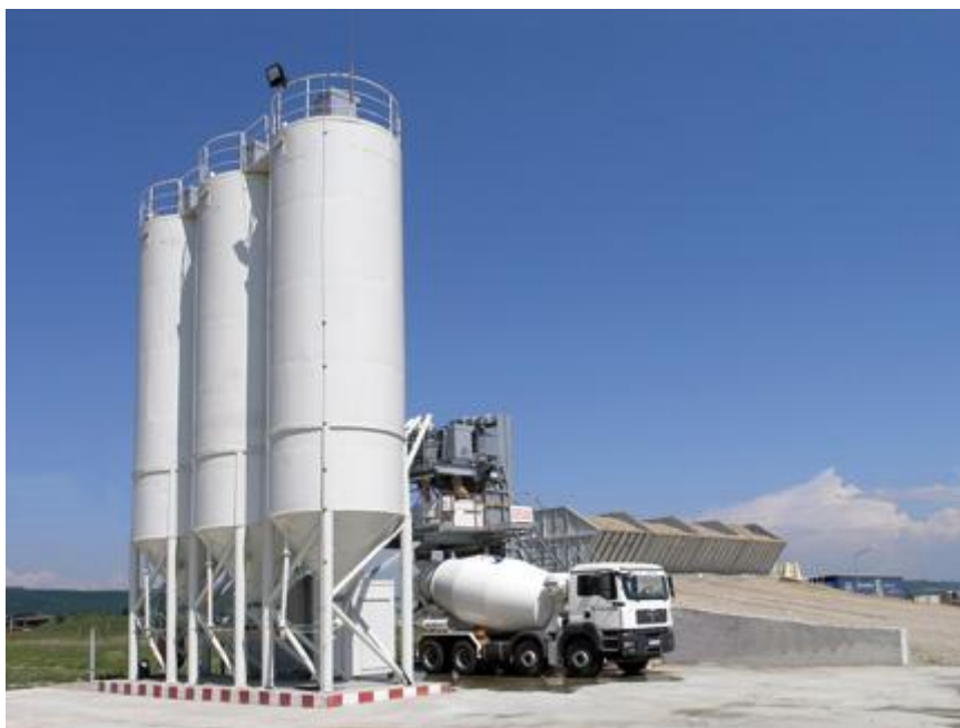
Rysunek 2 Przykładowy widok na węzeł betoniarski
