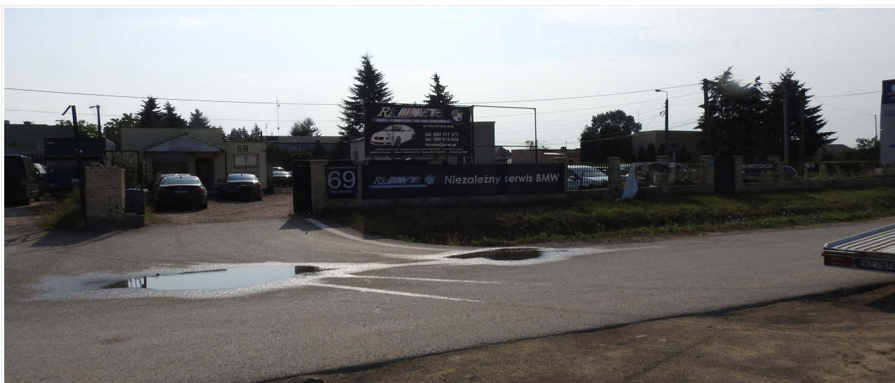
Fot. 1. Działka inwestycyjna ,widoczne istniejące zabudowania. Widok w kierunku wschodnim.
