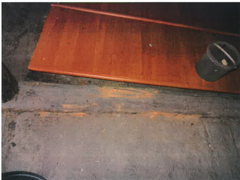
Zdj.1 –strop nad parterem
