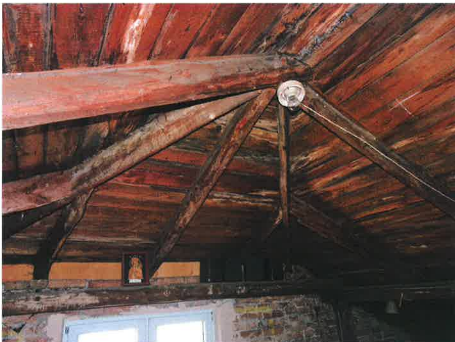
Zdj.7- więźba dachowa i deskowanie dachu w części zachodniej budynku
