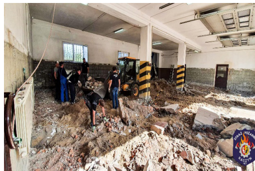
Remont garażu OSP Raszyn
