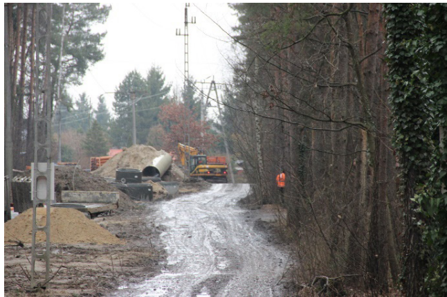
Prace kanalizacyjne w ul. Księżnej Czwertyńskiej
