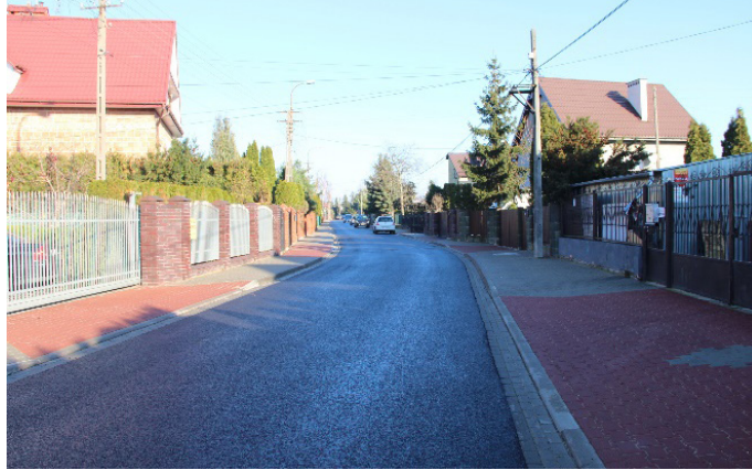
UL. WARYŃSKIEGO ul. Waryńskiego po remoncie Koszt inwestycji: 1 154 266,54 PLN
