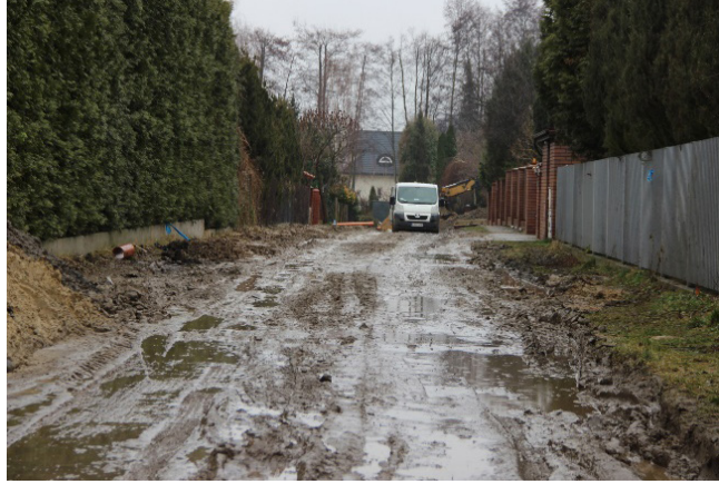
Prace kanalizacyjne w ul. Czarnej Olchy
