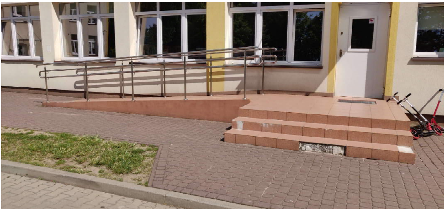
16.2. Schody przed wejściem do kuchni.
